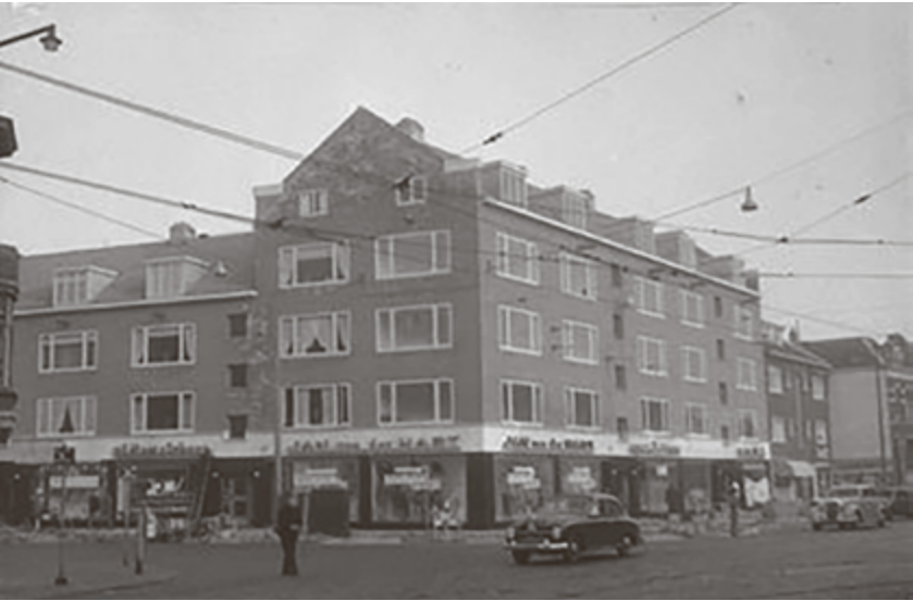
Nieuwbouw uit de jaren vijftig op de hoek van de Kleiweg en Straatweg.
