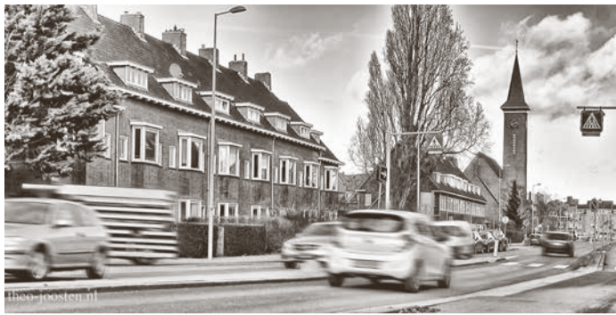
Huizen aan de Rozenlaan worden geïsoleerd (foto: Theo Joosten)
