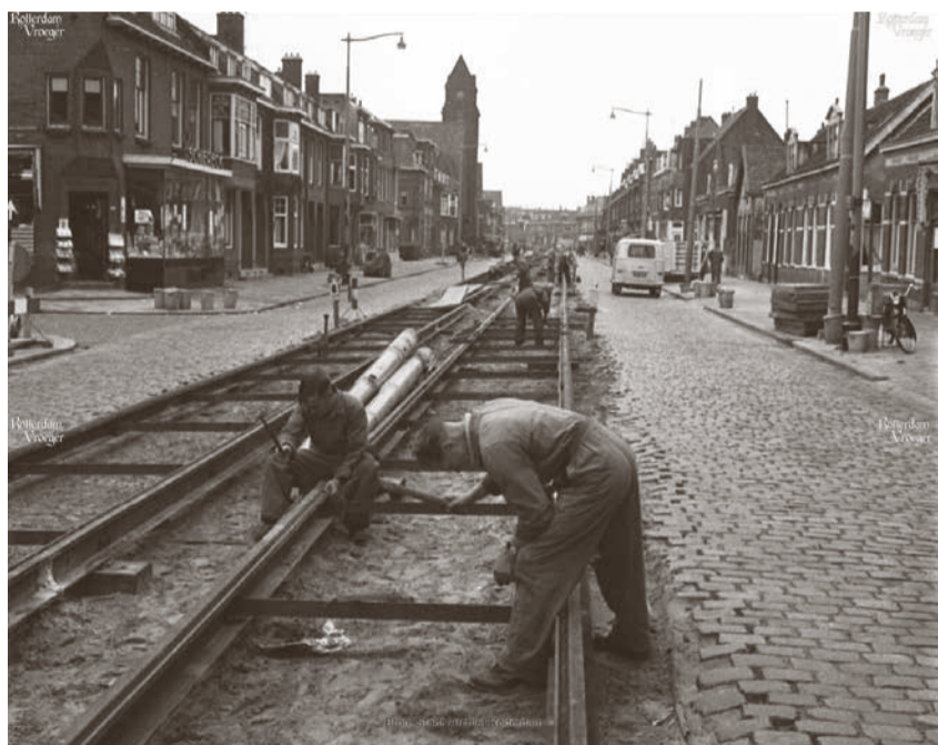
De aanleg van de tramrails op de Kleiweg rond september 1960. (foto: collectie Ton van Eijsden)
