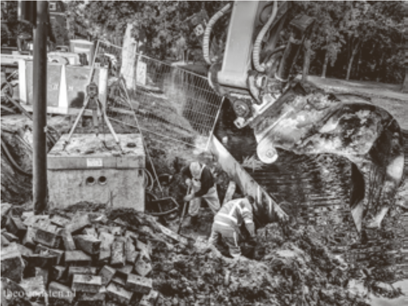
Begin oktober werd de pompput op de hoek van de Erasmussingel en Smaragdstraat geplaatst en vonden de afrondende werkzaamheden plaats. (foto: Theo Joosten)
