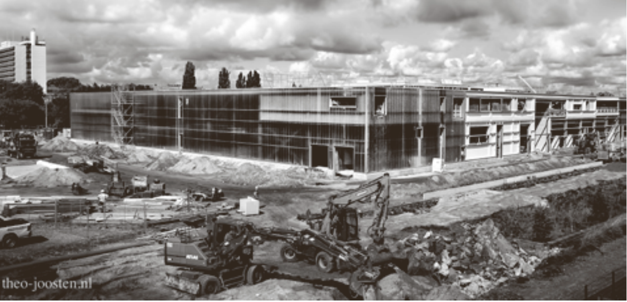
Blik vanaf het Rozenlaanviaduct op de nieuwbouw van de centrale werkplaats van de RET. (foto: Theo Joosten)
