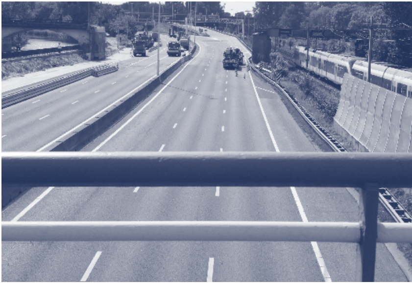
De sloop van de spoorbrug maakte een langere oprit mogelijk. Deze maatregel had positief effect op de veiligheid en de doorstroming van het verkeer. Hier was geen experiment voor nodig.
