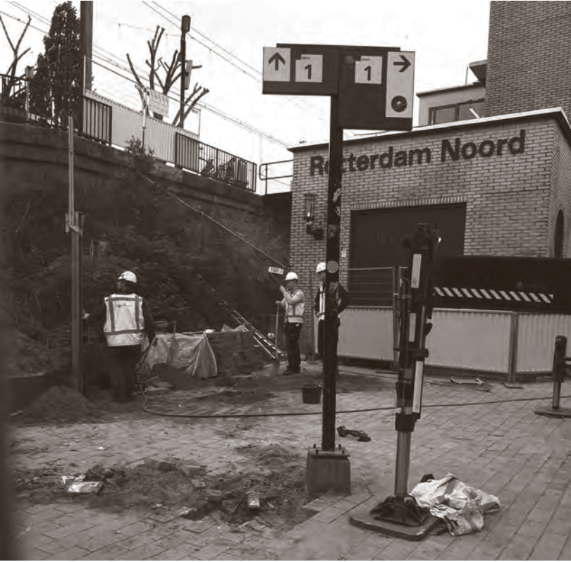
Start van de werkzaamheden aan Station Noord, de trap is al verwijderd. (foto: John Hokke)
