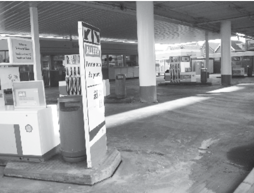
Het Shellstation aan de Uitweg zag er even verlaten uit maar is sinds dinsdag weer vol in bedrijf. Volgens de baliemedewerker is er een nieuwe vloer gestort op de plek waar de auto's tanken. In de winkel is verder niets veranderd.
