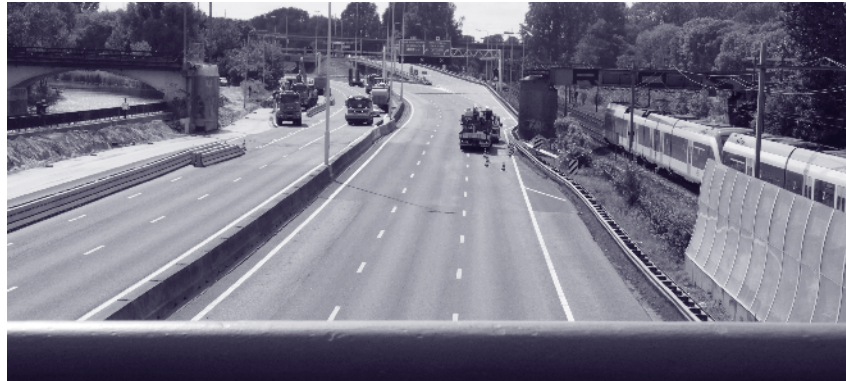
De A20 tijdens het afbreken van het Hofplein viaduct in het weekend van 28 augustus 2011
