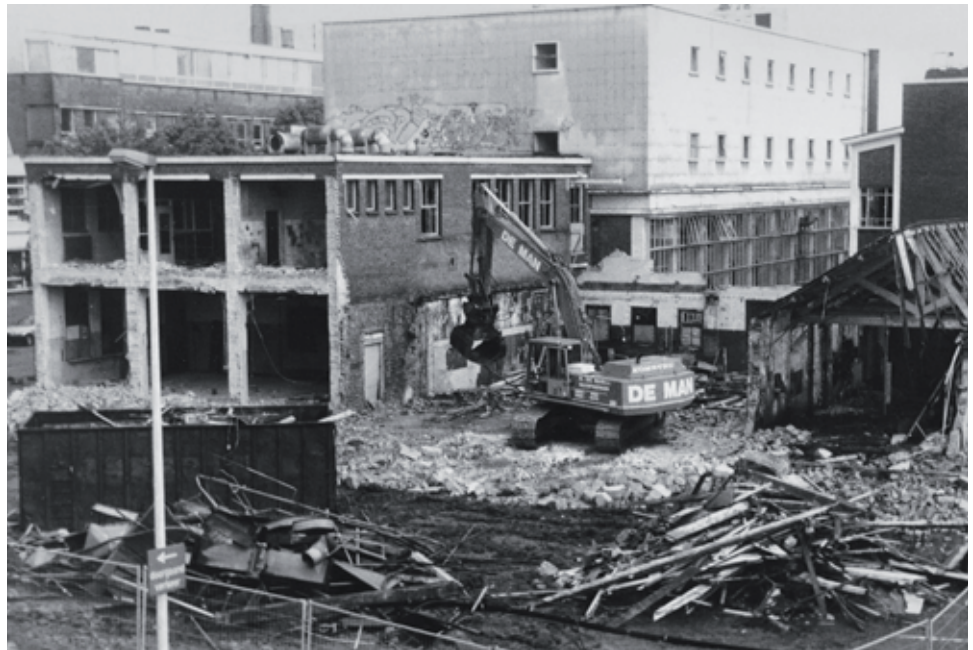
De sloop van de Elektro-stoom (BBC) gebouwen, gezien vanuit de Jan Willem Frisostraat.
